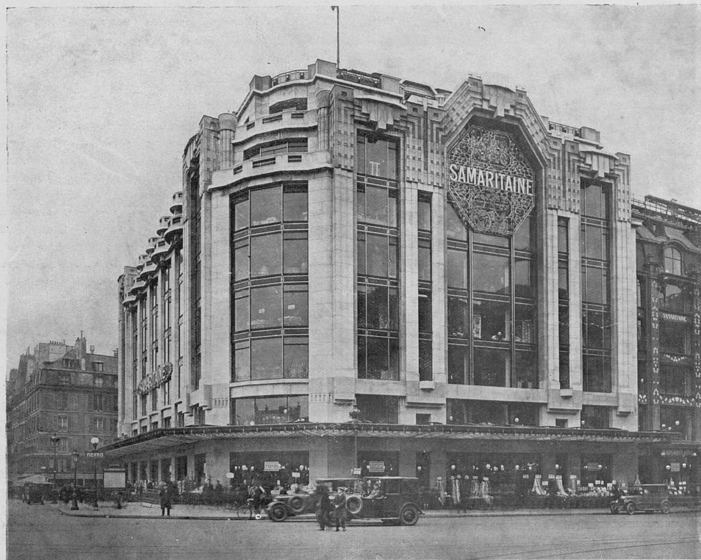
FRANTZ-JOURDAIN ET HENRI SAUVAGE, ARCHITECTES. — FAÇADE PRINCIPALE DE LA SAMARITAINE
